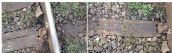
Traversele nr +3 și nr.+4 capătul corespunzător șinei din partea dreaptă a sensului de mers (firul interior al curbei)
