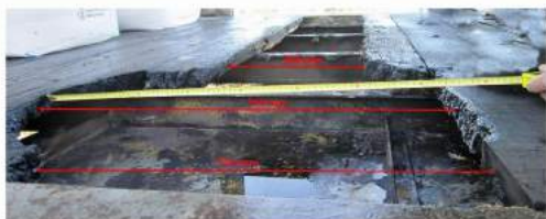
Foto nr.4, zona din podeaua vagonului afectată în urma producerii incidentului
