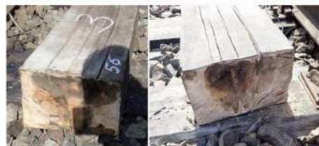
chitul nr. 3 - inimă roșie, crăpături dinspre fața superioară spre interior, formare secțiuni de rupere
