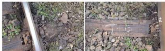
Traversele nr +5 și nr.+6 capătul corespunzător șinei din partea dreaptă a sensului de mers (firul interior al curbei)
