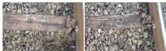
Traversele nr +7 și nr.+8 capătul corespunzător șinei din partea dreaptă a sensului de mers (firul interior al curbei)
