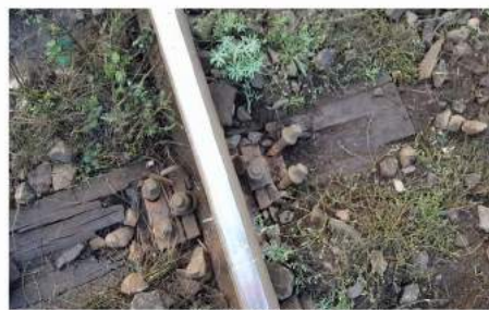
Punctul A - traversa nr.-1 (firul interior al curbei - șina din partea dreaptă a sensului de mers)
